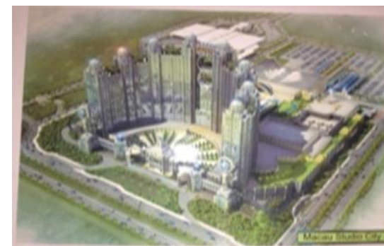
新濠影匯建築工程
