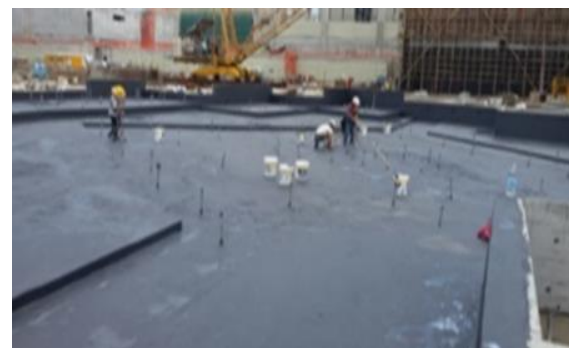
新濠影匯建築防水工程
