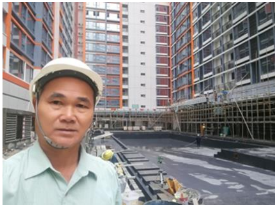
檢查水池防水
