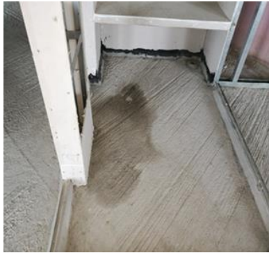
浴室安裝鋼鐵骨架
