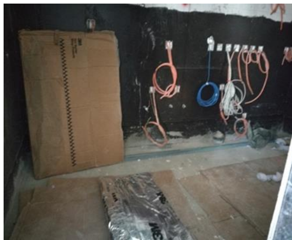
安裝供電設備
