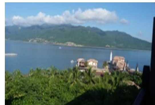
參與海南省分界洲島建設
