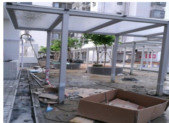
安裝鋼化玻璃幕牆
