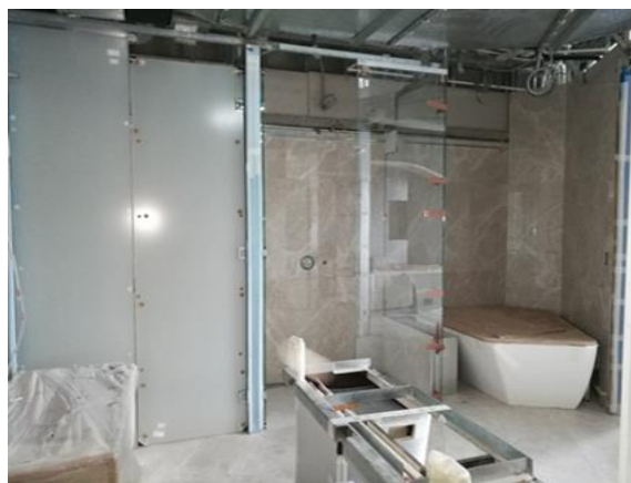
浴室鋼鐵骨架及玻璃門
